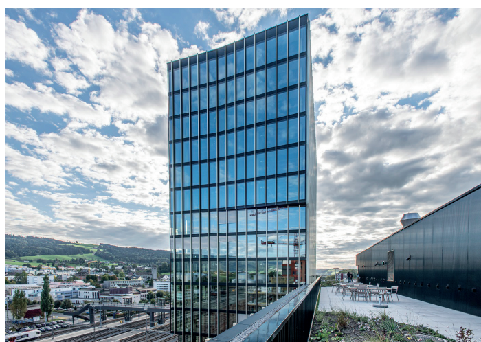
Abbildung 19: Hochhaus Arbo, Rotkreuz
