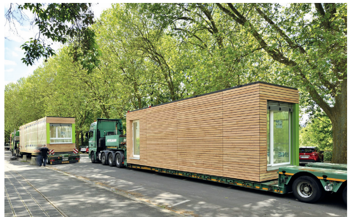
Abbildung 10: Raummodule aus Holz auf dem Tieflader
